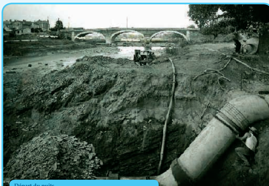
Départ du puits pose de la canalisation Juillet 1961 - Archives ALM
