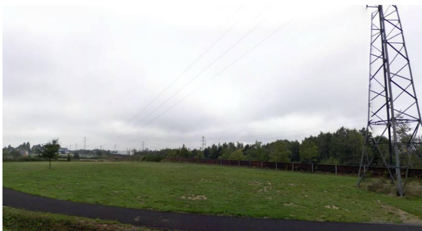
Figure 3 : Ligne haute tension surplombant le site
