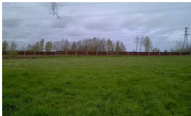
Figure 58 : Mur anti-bruit en fond de parcelle
